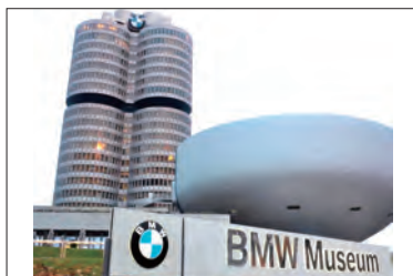
BMW本社ビル（左の建物）の外装パネルは、当社京都本社で作ったアルミ鋳物製です
