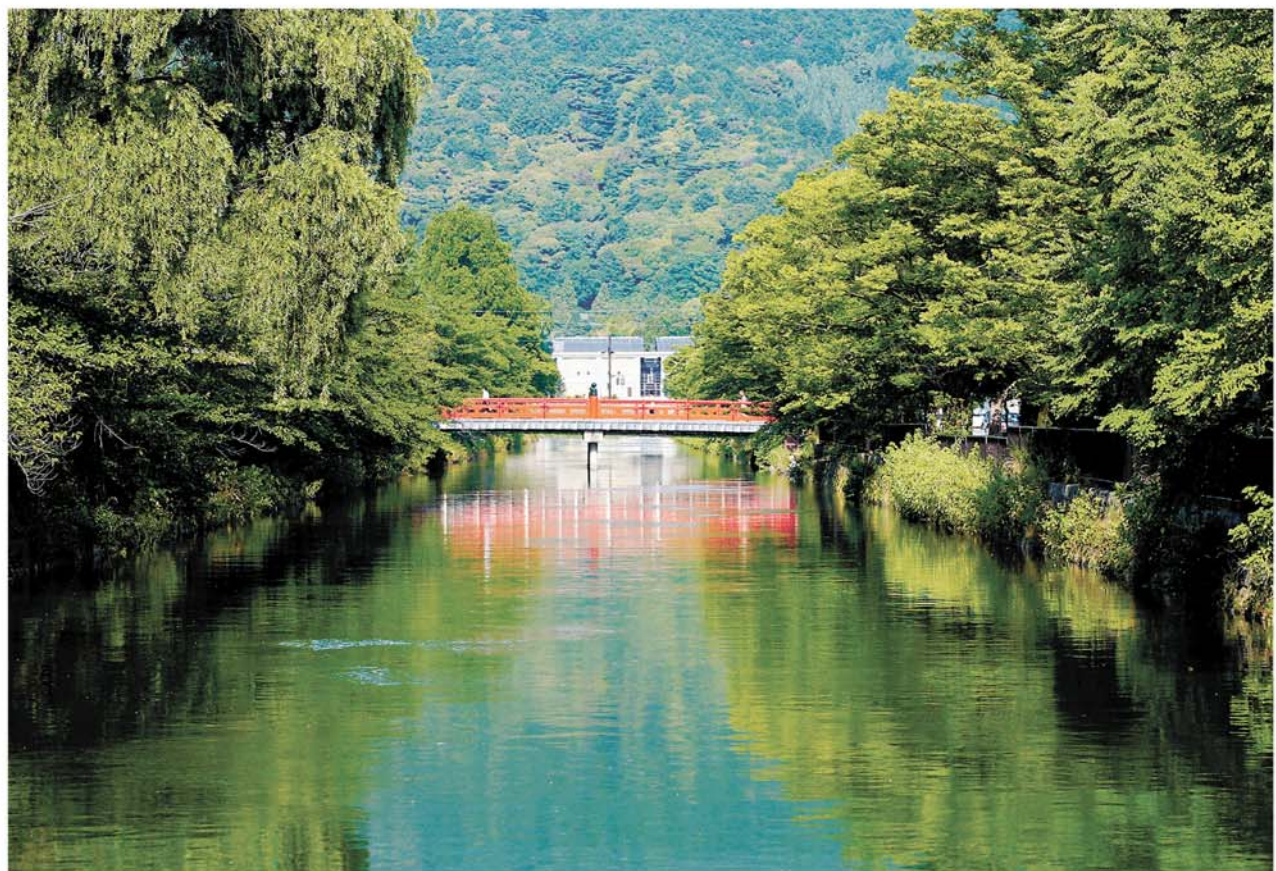
琵琶湖疏水がこれまで果たし、今も現役で担う役割は、琵琶湖から宇治川を結ぶ水運をはじめ、京都の上水道、工業用水、水力発電、さらにかんがいなど多岐にわたる。日本初の電車開業も、疏水による電力供給のおかげだった(京都市左京区の岡崎公園そばを流れる疏水。付近は戦前、市民が憩う水辺でもあった)
